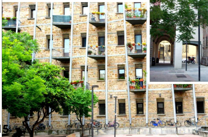
Firenze, recupero del complesso delle Murate Comune di Firenze (PU 1998 – in corso)
