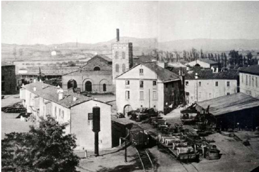
Figura 70 - Foto storiche dell'impianto siderurgico di Follonica, ancora collegato a Massa Marittima attraverso la ferrovia
