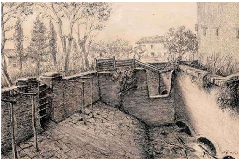
Figura 66 - "Il disegno raffigura lo spazio interno del forno di Valpiana dove l'acqua del bottaccio entrava e, scivolando in questa superficie molto inclinata, prendeva la spinta per immettersi nelle ruote motrici a pale"
