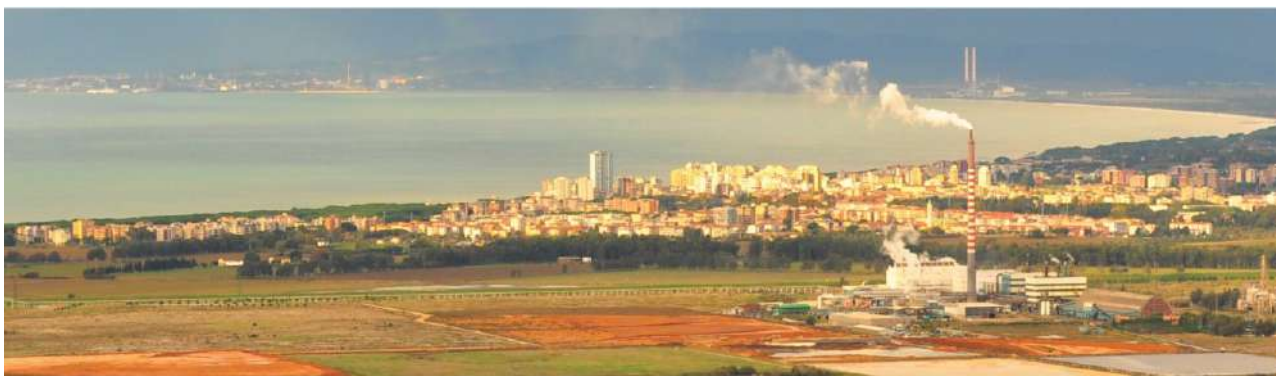
Figura 14 - Vista del Golfo di Follonica da Scarlino, con in primo piano il polo industriale e la città di Follonica.
