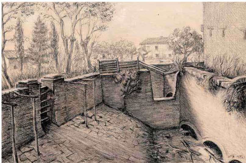
Figura 66 - "Il disegno raffigura lo spazio interno del forno di Valpiana dove l'acqua del bottaccio entrava e, scivolando in questa superficie molto inclinata, prendeva la spinta per immergersi nelle ruote motrici a pale"
