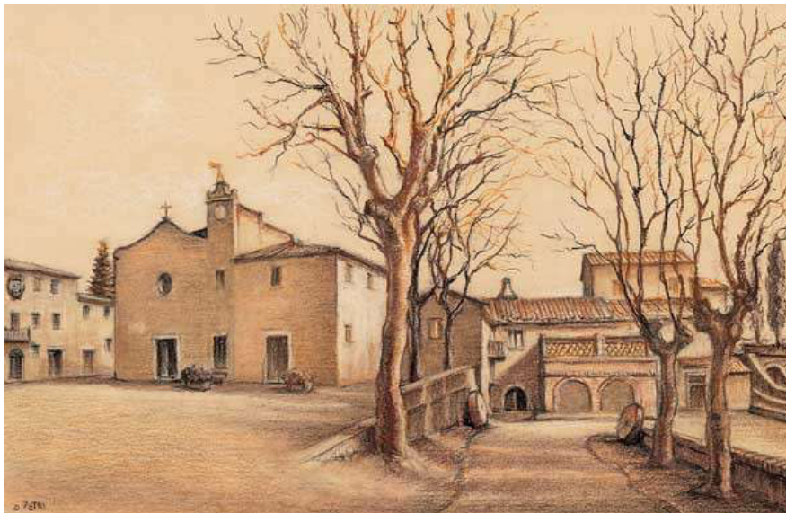
Figura 64 -Nel disegno è raffigurata la palazzina dei Ministri con lo stemma Mediceo nel villaggio industriale di Valpiana. Sulla destra si vedono i muri che canalizzavano le acque d'uscita dal gran bottaccio.
