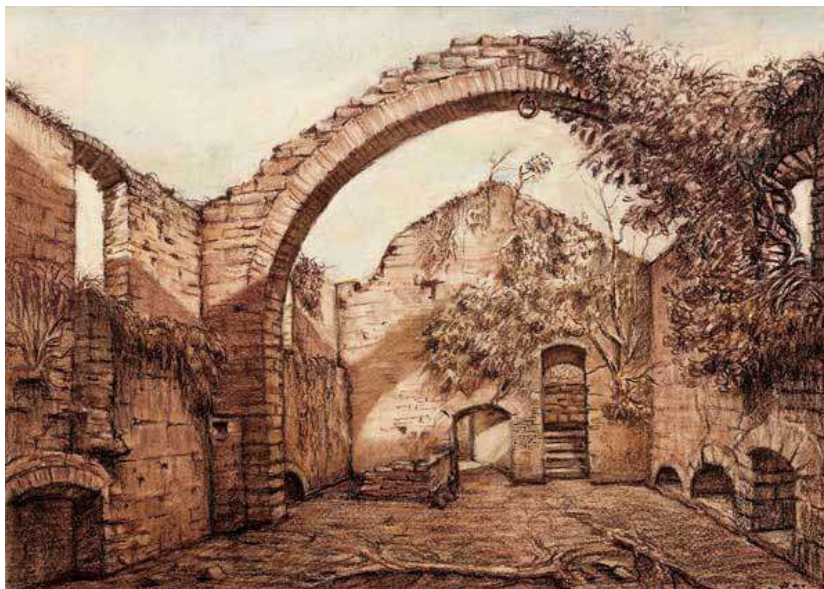
Figura 69 - "Questo disegno raffigura il grande spazio interno della ferriera collegato da un arco a tutto tondo dove è ancora inserito quell'anello che tramite verricelli serviva a sollevare gli oggetti pesanti. Intorno nicchie, scale e cunicoli".
