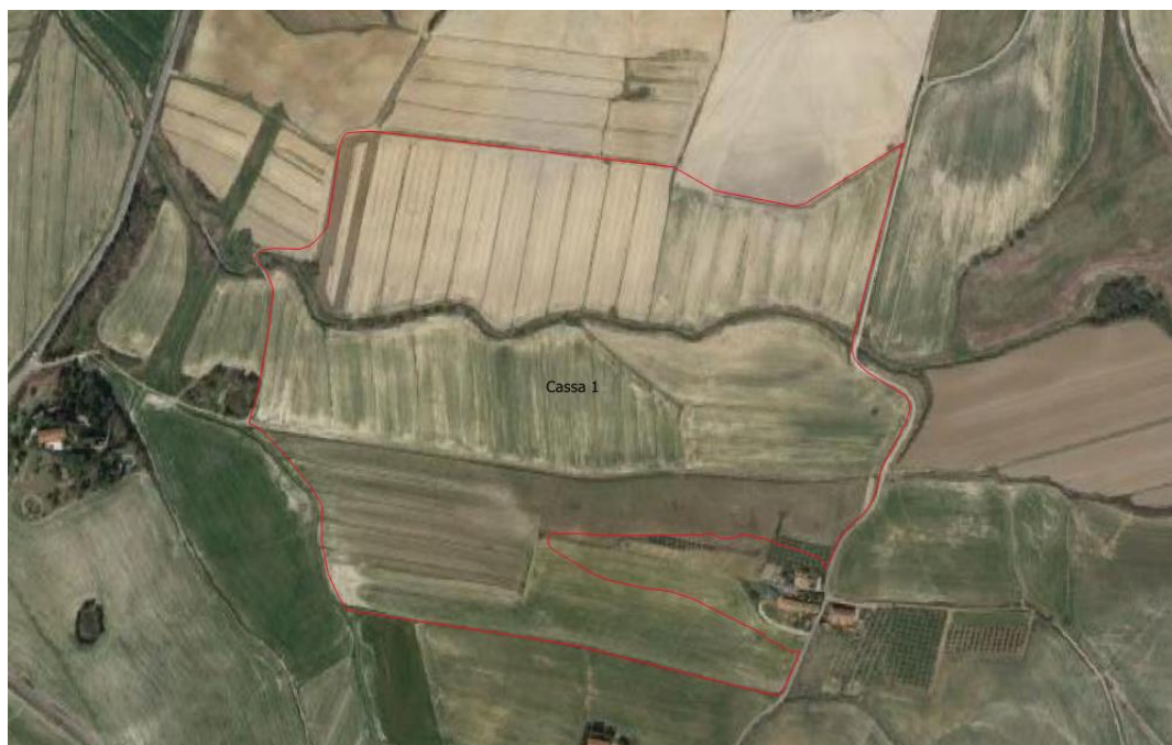
Figura 7 – Cassa di espansione 1 sul Torrente Tora
