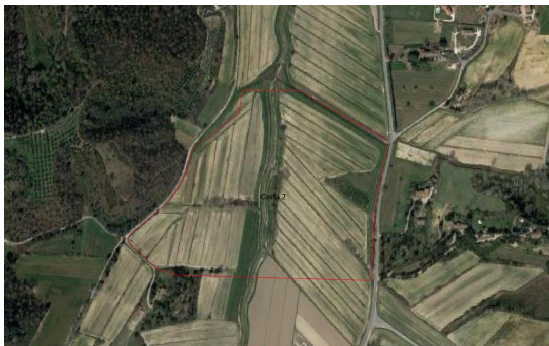
Figura 8 – Cassa di espansione 2 sul Torrente Tora
