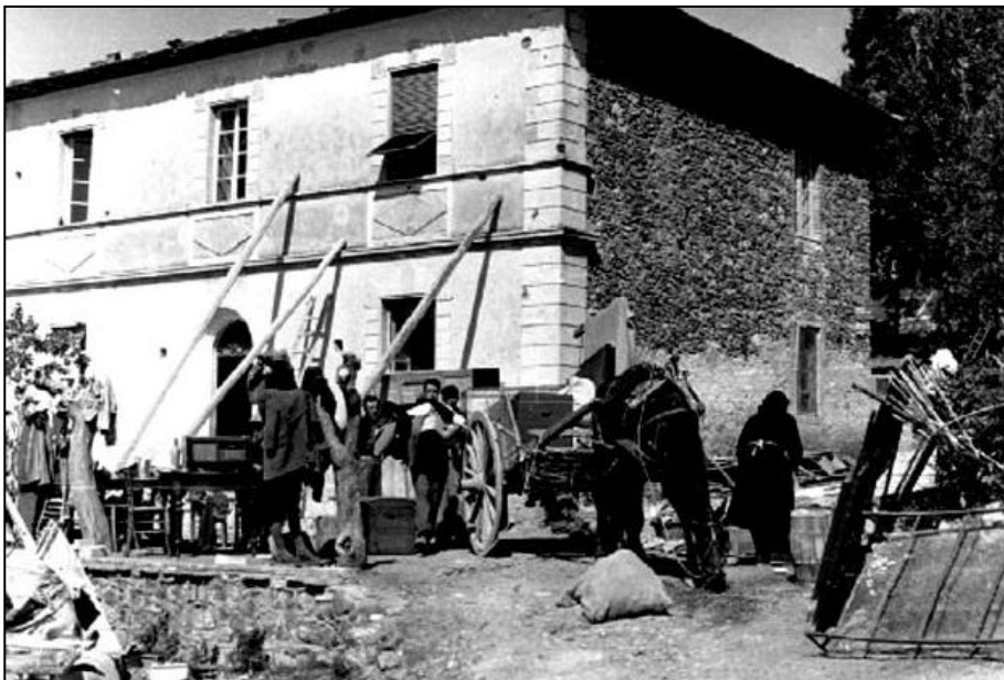
Foto 2. Edificio puntellato in seguito al sisma del 1950 (Foto archivio storico Luciano Ciriello)
