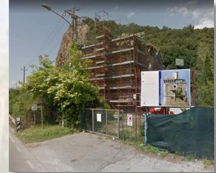
Stato del Restauro (agosto 2019)
