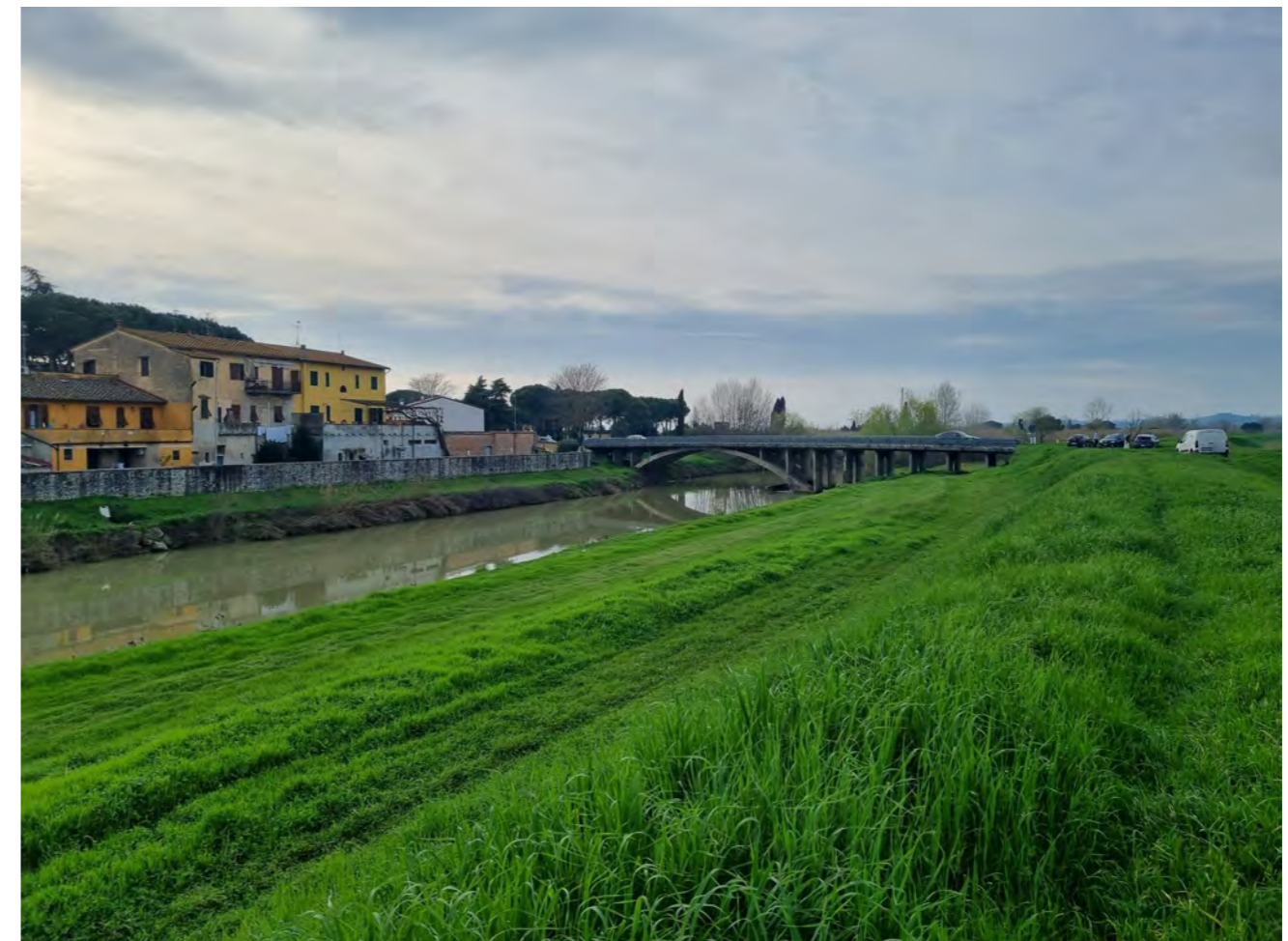
a/Ponte sulla SS67
