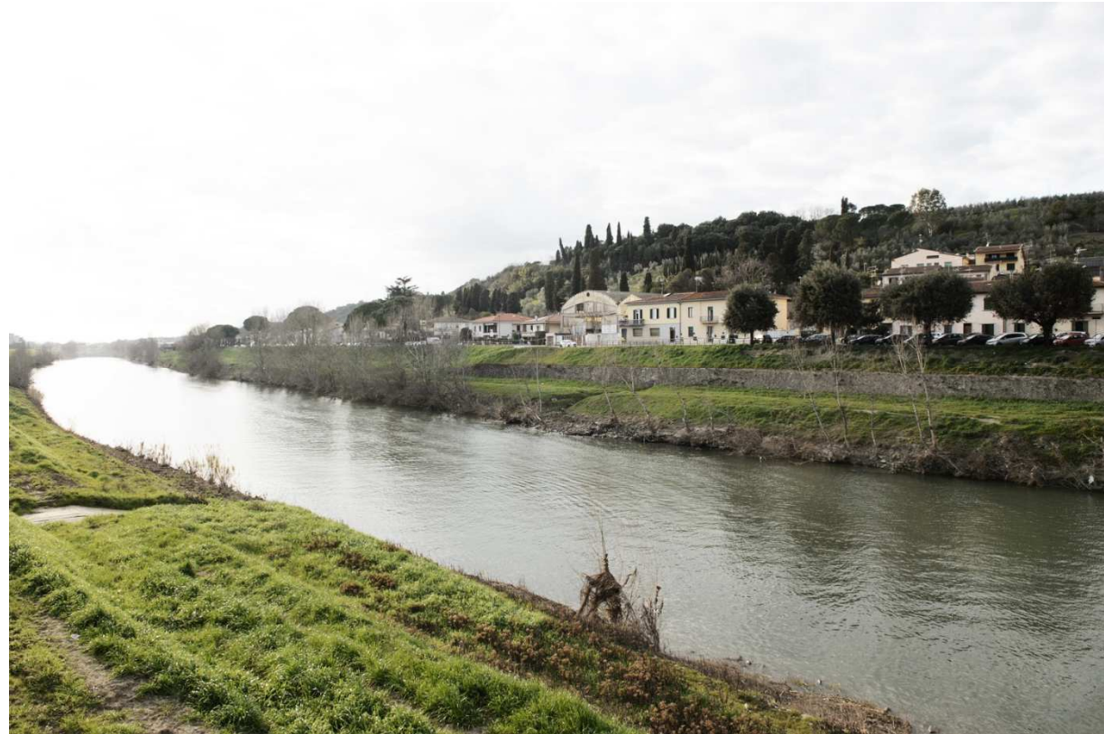
Figura 6 Foto 1, vista da Via della Tinaia
