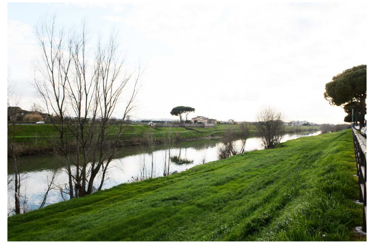
Figura 9 Foto 4, vista da Viale Montagni
