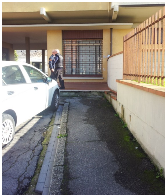
Lo spazio sul marciapiede su cui realizzare una rampa
