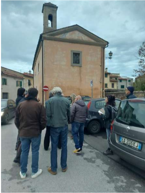
La facciata posteriore dell'ex chiesa di San Girolamo. Foto a cura di Simurg Ricerche
